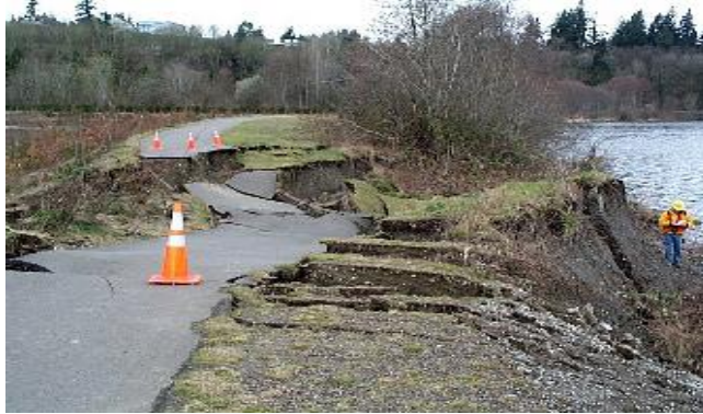
图 1-3 液化导致湖堤侧向滑动
