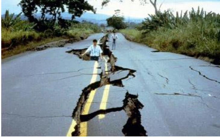
图 1-5 不存在临空面的液化侧移
