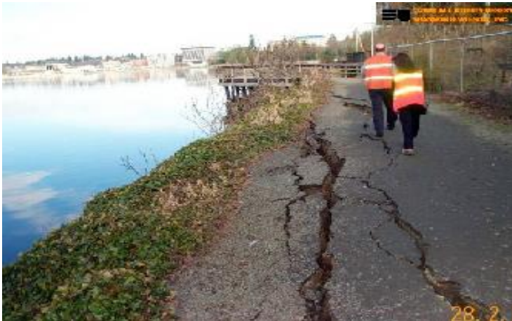
图 1-6 存在临空面的液化侧移
