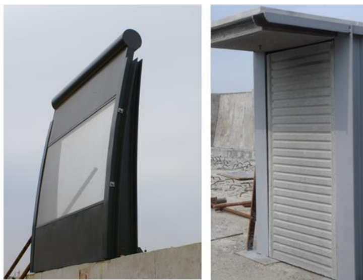
图 1.13 半高声屏障及疏散平台下吸声板
