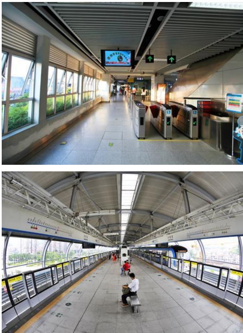
图 1.16 高架车站站厅、站台层实景照片
