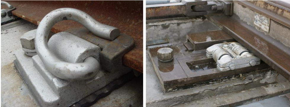
图 1.12 DT-Ⅲ型小阻力扣件及道岔辊轮
