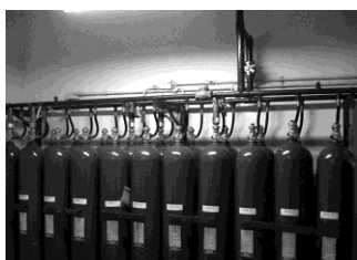
图 1-4-22 气体灭火系统组成
