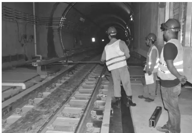
图 1-4 地铁验电操作
