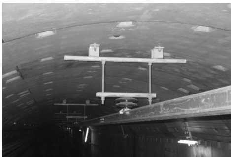
图 1.1.7 隧道架空式 (刚性) 接触网
