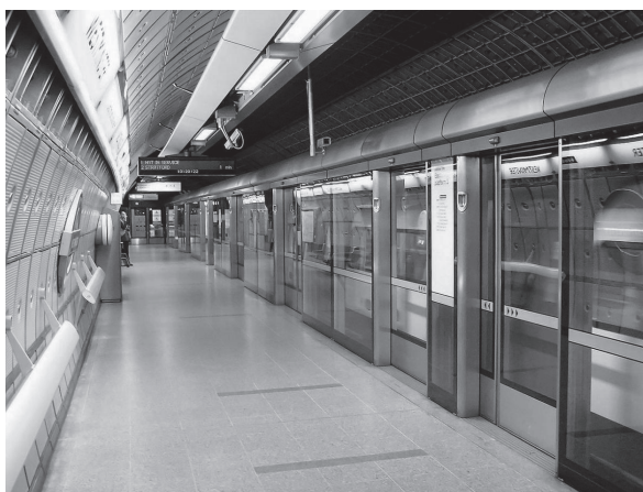
图 1-1-1 城市轨道交通车站安全门实景图
